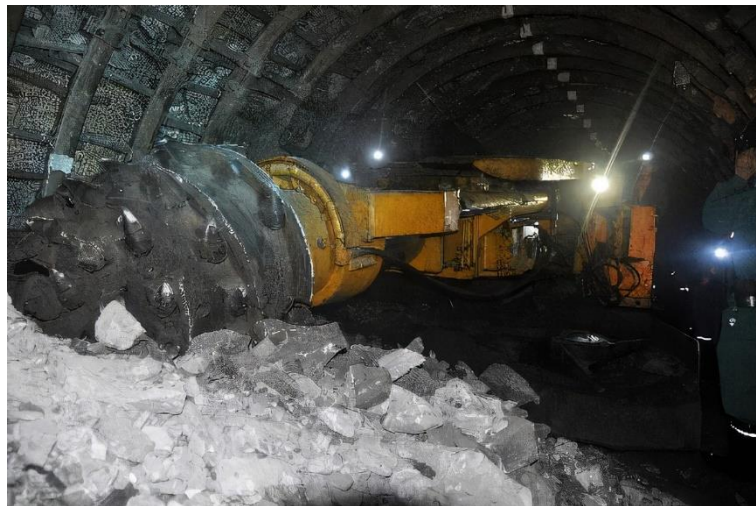
图 1 综掘机械设备
