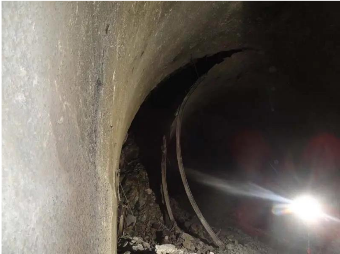
图 3 破碎围岩巷道
