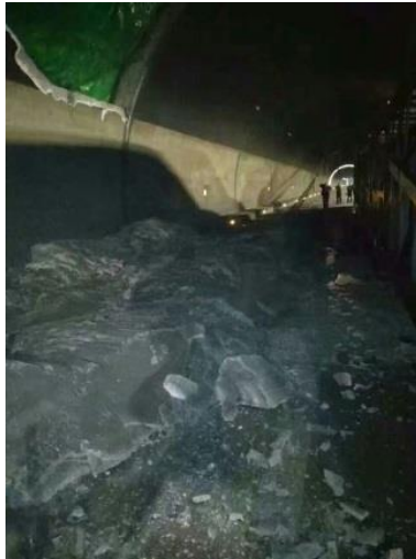
图 1 顶板垮落
